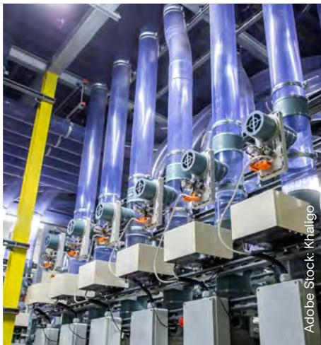
Moderne Rohrpostsysteme transportieren Proben, Medikamente und Dokumente automatisiert durch Klinikgebäude – schnell, sicher und digital vernetzt. Über RFID-Tracking, OPC-Schnittstellen und Anbindung
