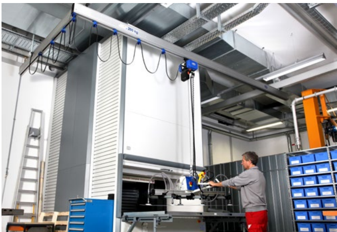
Aluminium-Einträgerkrananlage mit Vakuum-Hebegerät VacuMaster Basic bei der Beschickung eines Hochregallagers
