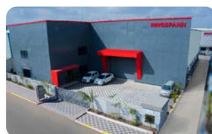
RINGSPANN Power Transmission India Pvt. Ltd., Indien
