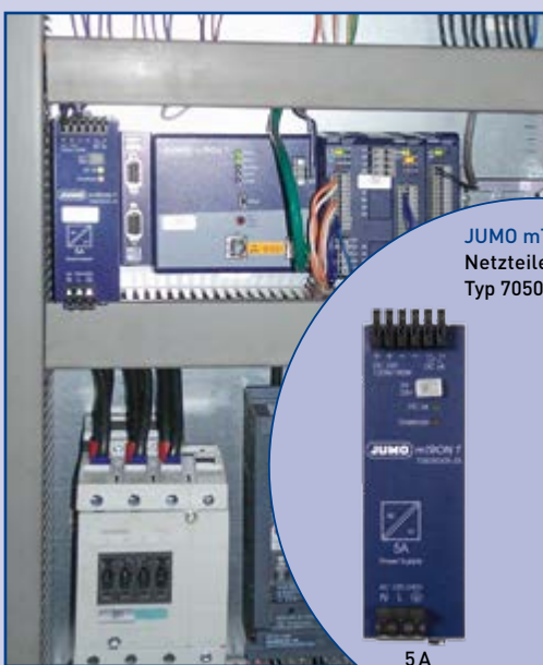
JUMO mTRON T im Schaltschrank für Temperaturregelung Turmofen
