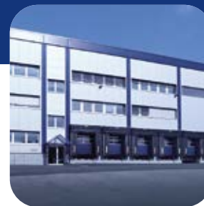
Inbetriebnahme des neuen Zentrallagers 2013
